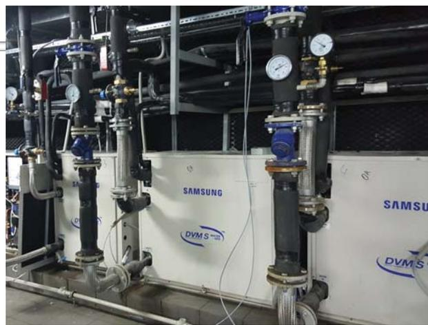
Рис. 3. Наружные блоки DVM S Water установлены в техническом помещении цокольного этажа вокзала
